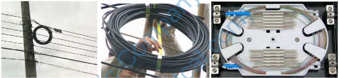
ภาพประกอบที่ 2.12 เคเบิลจากชุมสายสารภีไปสนามกอล์ฟกัสชันเส้น Fiber ในหัวต่อสภาพปกติ
