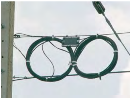
ภาพประกอบที่ 2.10 จุดแรกหัวต่อที่ Loop บนก่อนปลดลงมาและสภาพเส้น Fiber ที่เคลื่อนตัว
