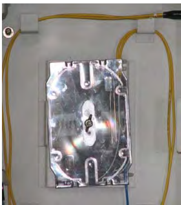
ภาพประกอบที่ 2.15 Distribution Box ในหอดูดาวและ Fix Loop ภายนอกก่อนเข้าอาคาร
