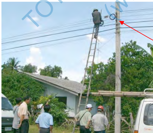
ภาพประกอบที่ 2.7 สภาพเส้น Fiber เคลื่อนตัวในหัวต่อหน้าโรงแรมเฟลิกซ์
