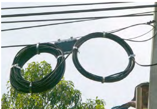
ภาพประกอบที่ 2.11 จุดที่ 2 หัวต่อที่ Loop บนก่อนปลดลงมา และสภาพเส้น Fiber ที่เคลื่อนตัว
