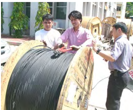
ภาพประกอบที่ 3.31 คลี่สาย Optical Drop Cable ออกจากระวิงและวัดอัตราการเคลื่อนตัว
