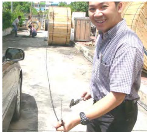
ภาพประกอบที่ 3.31 คลี่สาย Optical Drop Cable ออกจากระวิงและวัดอัตราการเคลื่อนตัว
