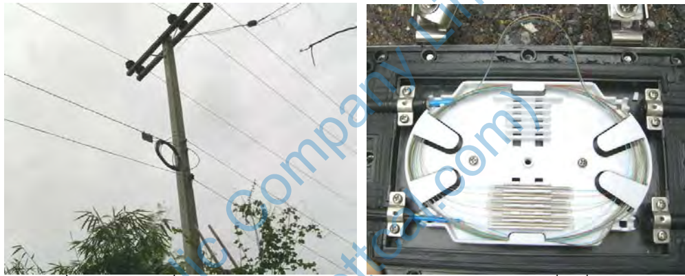
ภาพประกอบที่ 2.13 หัวต่อที่ Loop บนก่อนปลดลงมา และสภาพเส้น Fiber ที่เคลื่อนตัวออกในหัวต่อ
